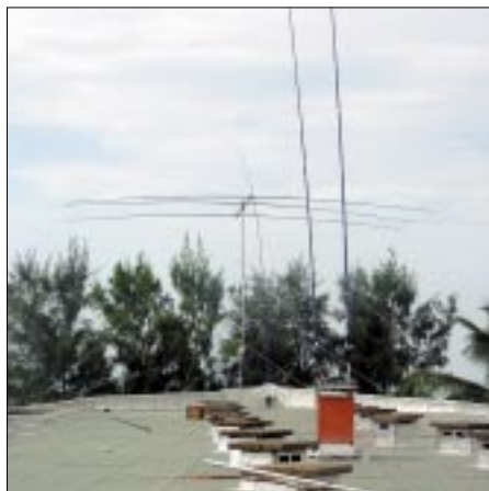
Auf dem Combo Beach Hoteldach: 3-Element-Beam, Dipole und Vertikals fanden dort Platz
